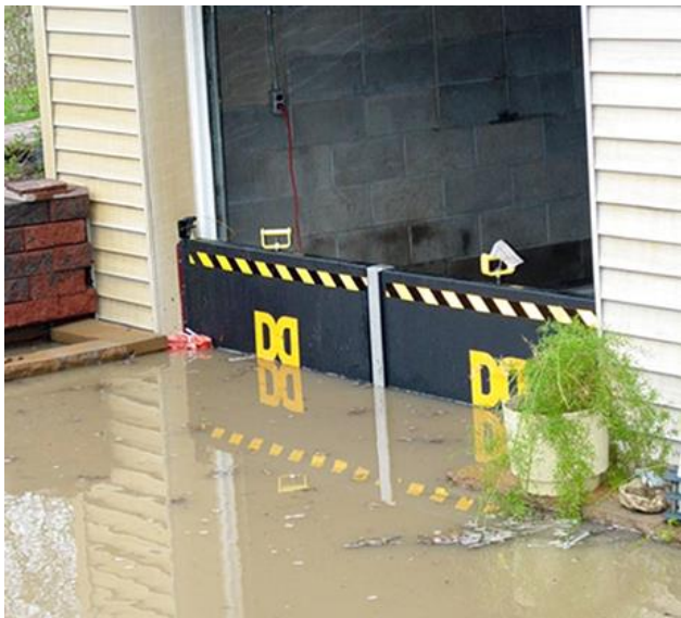
Schotten in geleidingsrails geschoven
